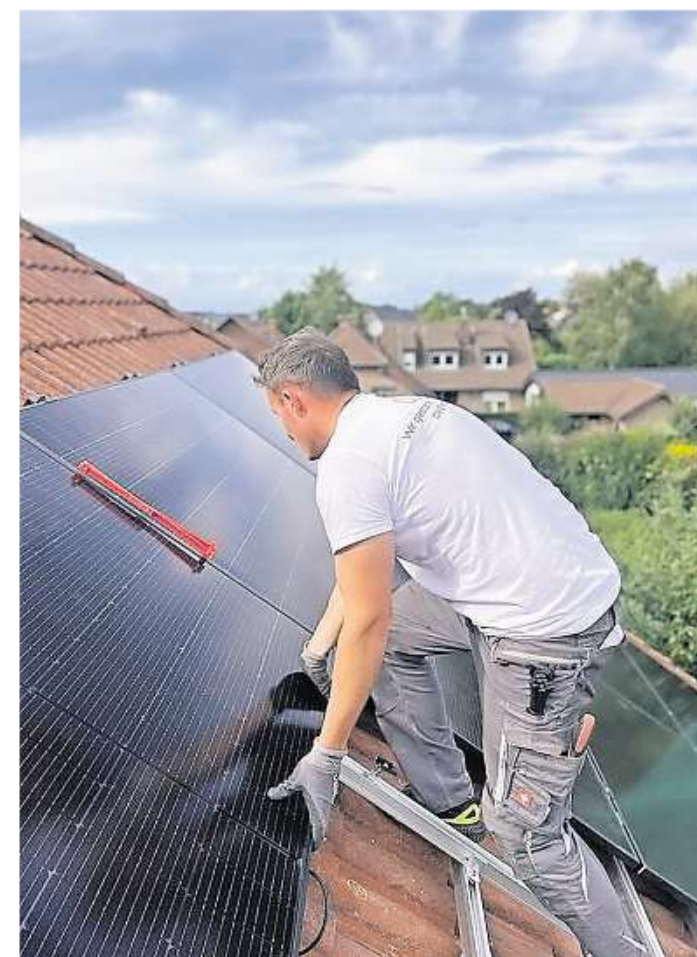
Bei Lara Future steigt der Chef zur Montage der PV-Anlage selber aufs Dach.
