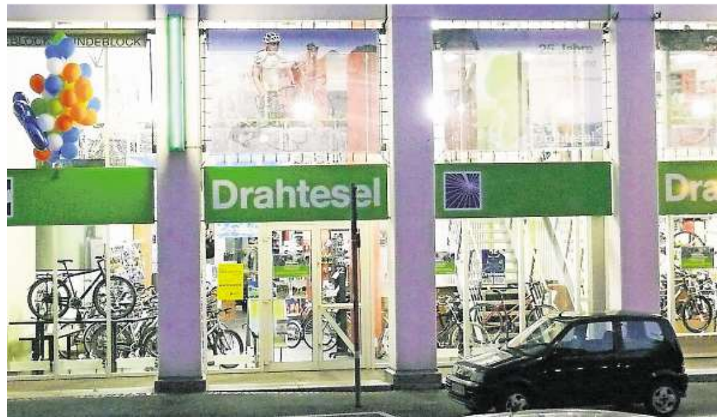
Der „DRAHTESEL“ in Bad Godesberg nach dem Umbau 2009.
