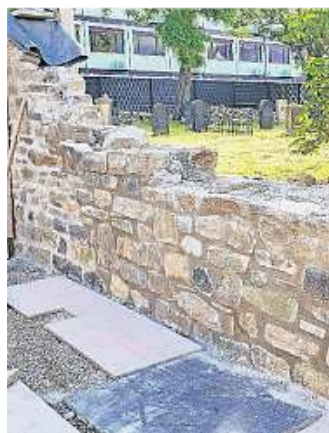
Der Wiederaufbau der Bruchsteinmauer am Jüdischen Friedhof an der Ahrweiler Schützenstraße.
